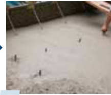
5 次のリフト用のアンカー筋準備
