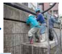
5 最上段コンクリート打設
