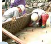
2 型枠パネル1段目の組立
