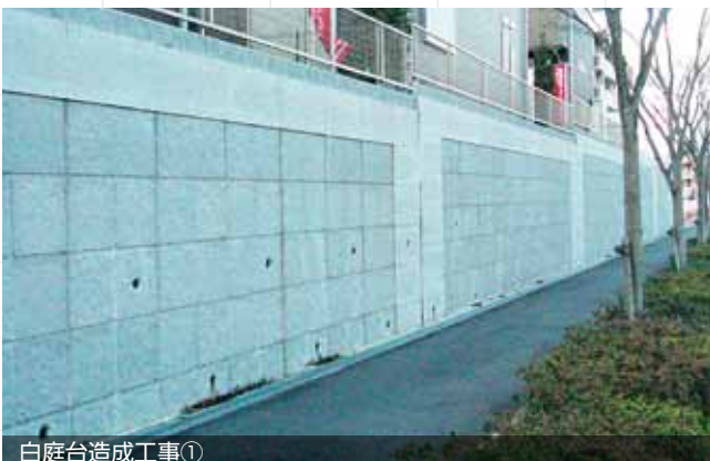
白庭台造成工事①
