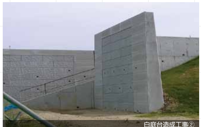
白庭台造成工事②
