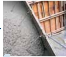
4 コンクリート打設
