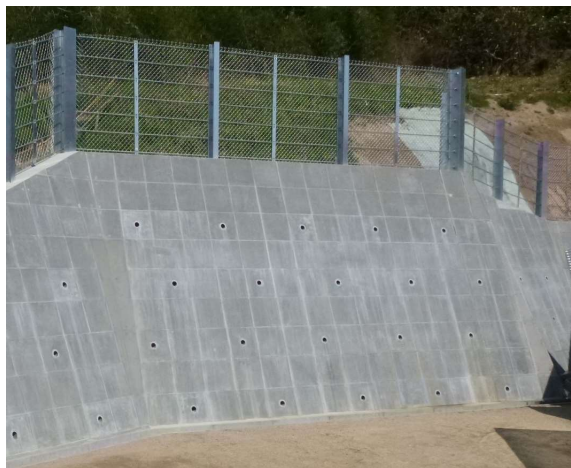
施工イメージ①
