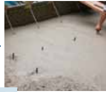
5 次のリフト用のアンカー筋準備
