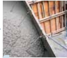
4 コンクリート打設
