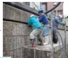
5 最上段コンクリート打設
